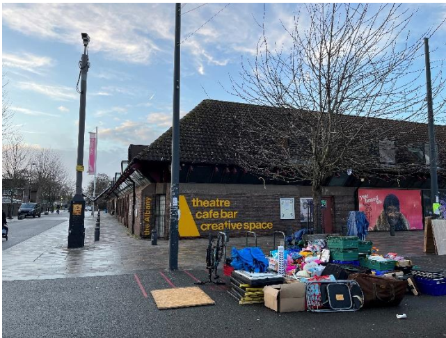
The Albany 外観
